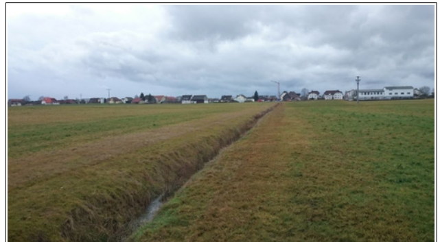
Abb. 4: Entwässerungsgraben an der östlichen Grenze
