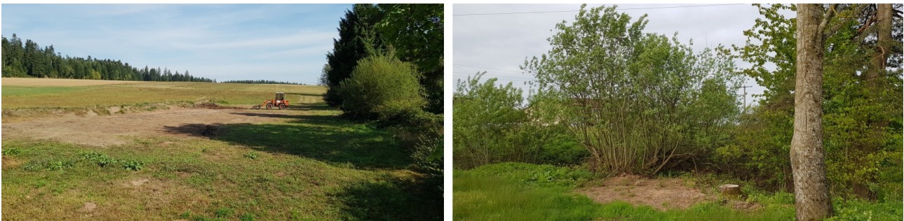
Abb. 19: Bodenarbeiten, Abschieben des Oberbodens 2022, gefälltter Großbaum 2023
